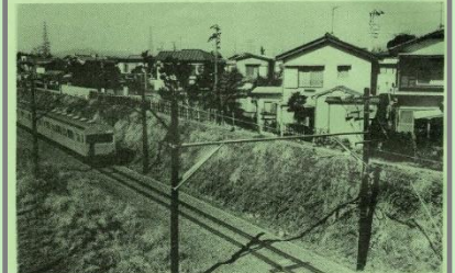
【戸倉橋より日吉町新和会の一角を望む】
